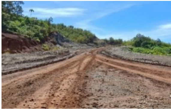
Gambar 6. Segmen 7 jalan keriting
