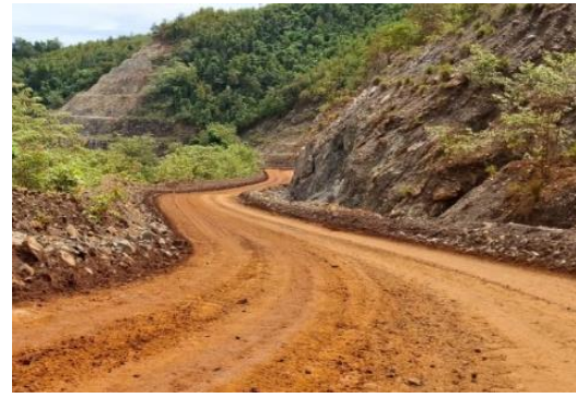
Gambar 7. Jalan kondisi baik
