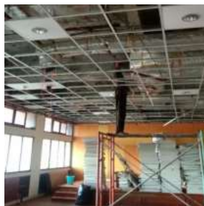
Gambar 8. Pekerjaan Tata Udara (Ducting) dan Instalasi Listrik (Sumber: Dokumentasi Pribadi).
