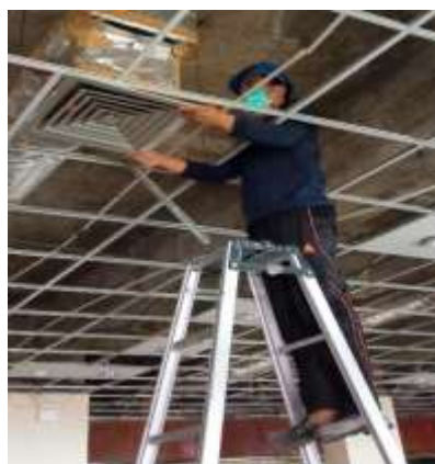
Gambar 8. Pekerjaan Tata Udara (Ducting) dan Instalasi Listrik (Sumber: Dokumentasi Pribadi).
