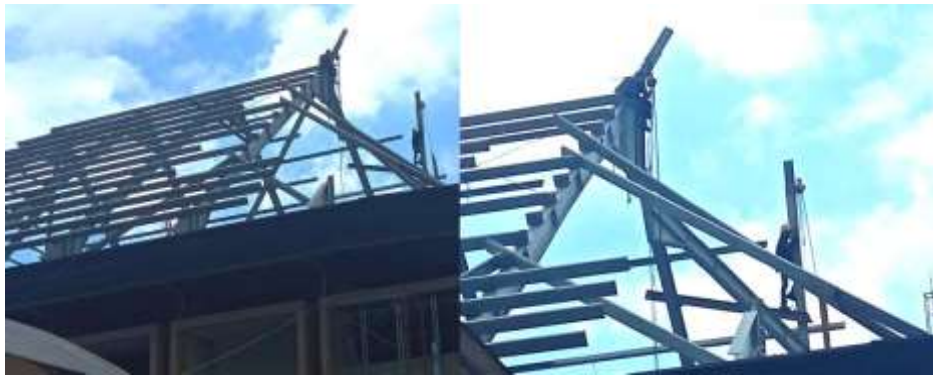
Gambar 5. Pemasangan Rangka Atap Baja (Sumber : Dokumentasi Pribadi)
