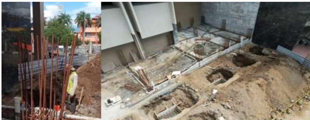
Gambar 6. pekerjaan galian tanah (Sumber: Dokumentasi Pribadi)
