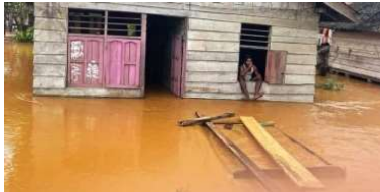
Gambar 2. Pemukiman yang tergenang banjir di Dusun Lukolamo
